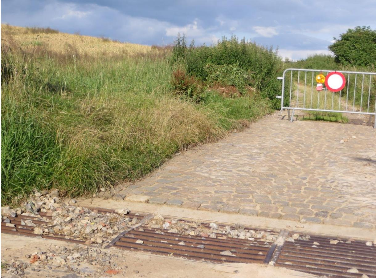
Le bas de la rue de Dinant passé le pont Pierre à guêtres est à chaque impacté lors de gros orages. L'eau et la boue arrivent en amont à hauteur du n° 54, elles proviennent du champ. La grille qui est posée à la sortie du champ ne prend quasi rien. L'eau et la boue passent à côté et s'écoulent directement sur la route. Cette grille devrait être dédoublée et l'espace entre les barreaux de la grille devrait être plus large.
